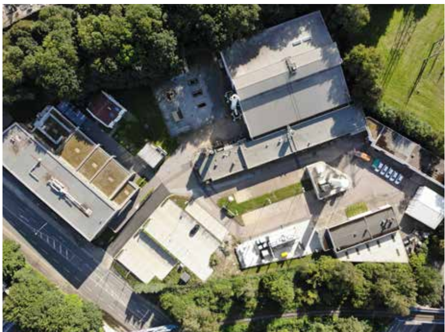
ABBILDUNG 3: BLICK AUF DEN INSTITUTSSTANDORT DES GAS- UND WÄRME-INSTITUTS ESSEN E.V., QUELLE: GWI, 2023
