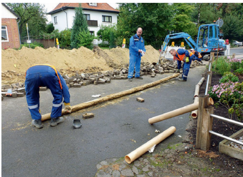
Abb. 5: Rohrprobenentnahme an einer Gasversorgungsleitung
