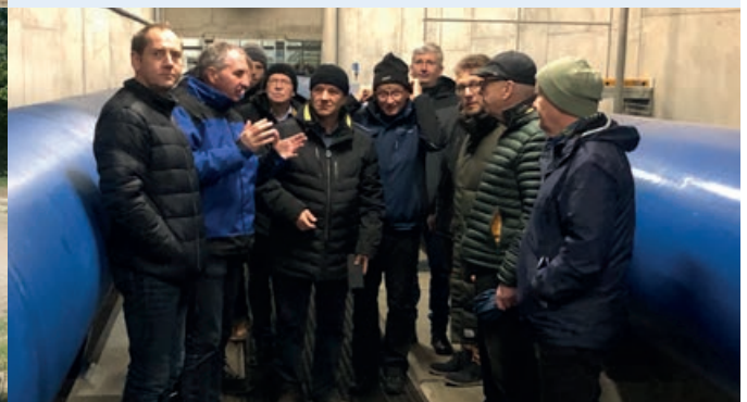
Ein Kollege der Thüringer Fernwasserversorgung führt die AK-Mitglieder durch die Wasserentnahmeeinrichtungen der Talsperre Schmalwasser
