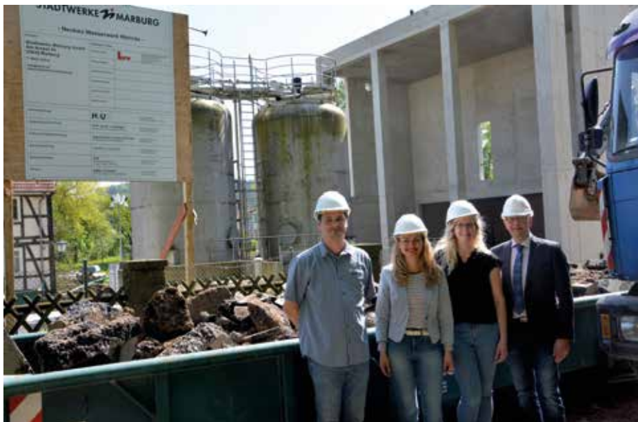
Von links: Tobias Culemann, Leiter des Wasserwerks der Stadtwerke, Bürgermeisterin und Stadtwerke-Aufsichtsratsvorsitzende Nadine Bernshausen, Projektleiterin Lara Eicher sowie Stadtwerke-Geschäftsführer Dr. Bernhard Müller vor dem Neubau des Wasserwerks Wehrda
