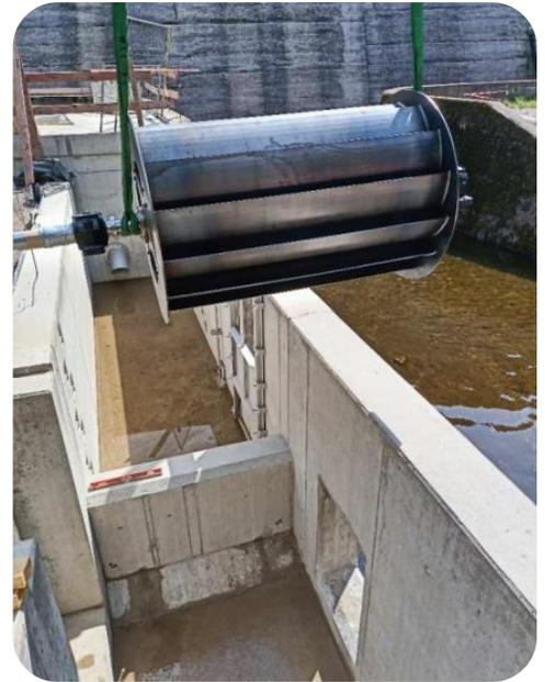
Abbildung 1: Wasserrad beim Einheben an den Montageort, © Schluchseewerk AG
