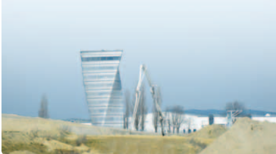
Baustelle des neuen Großflughafens BBI
