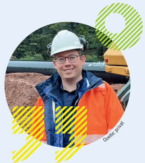
Bei Open Grid Europe ist Alexander Böskén für die Planung von Wartungs- und Instandhaltungsarbeiten im Erdgasnetz zuständig.
