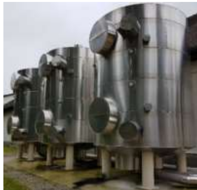
Abbildung 40: Aktivkohlefilterstufe zur Konzentratbehandlung
